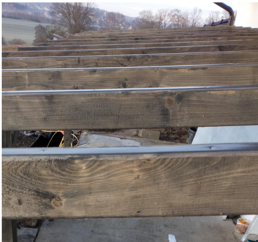
Obrázek 3 Těsnící pryž musí být na všech plochách, kde bude ležet deska
