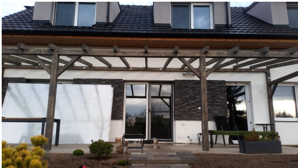
Obrázek 1 Připravená dřevěná konstrukce
