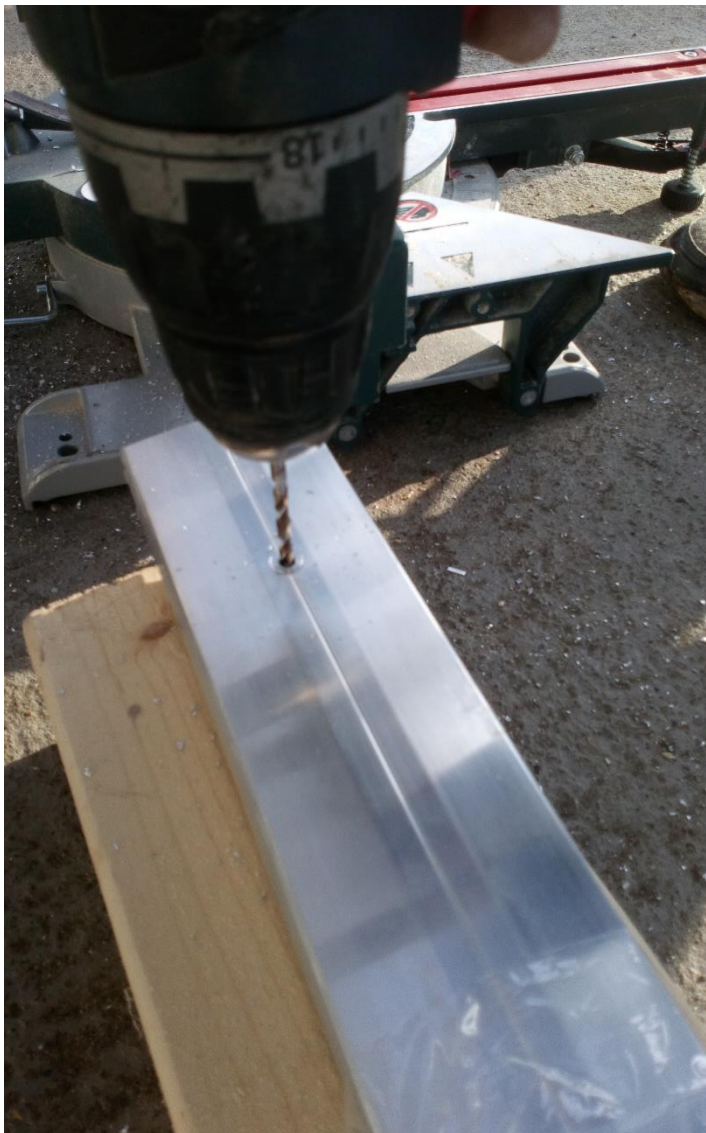
Obrázek 6 Díry na vruty předvrtáváme před pokládkou
