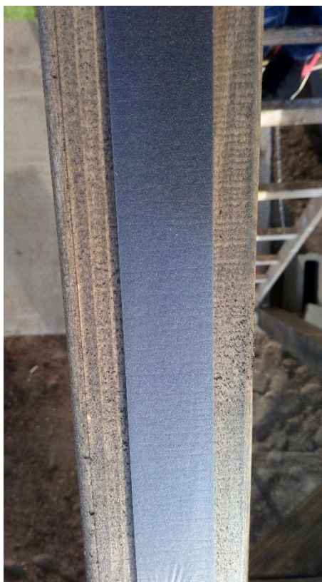
Obrázek 2 Detail krokve s těsnící pryží
