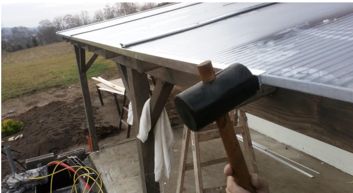
Obrázek 9 Ukončovací lištu jednoduše nasadíme, pomoci si můžeme gumovou palicí
